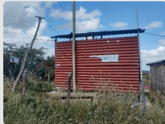
Foto 10 Sistema de poza séptica ventilada 3 De Abril 20/01/2023
