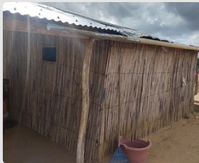
Foto 9 Adecuaciones en vivienda para recolección de aguas lluvias - 3 De Abril 20/01/2023
