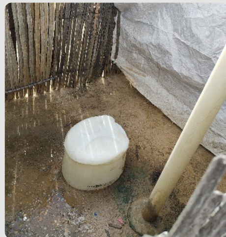
Foto 10 Sistema de poza séptica Nueva Venezuela 19/01/2023
