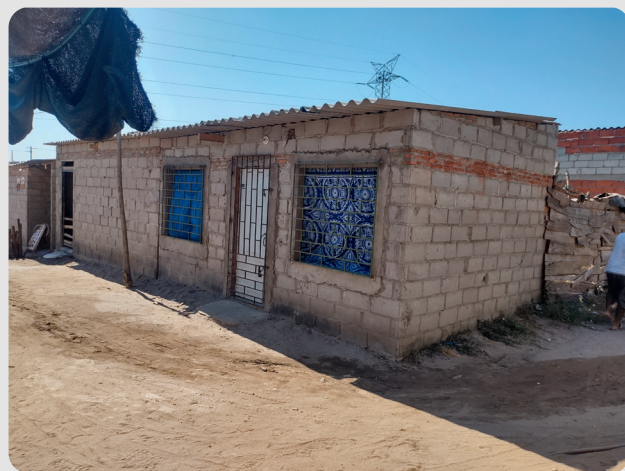
Foto 17 Vivienda en ladrillo del asentamiento Nueva Esperanza 2/02/2023
