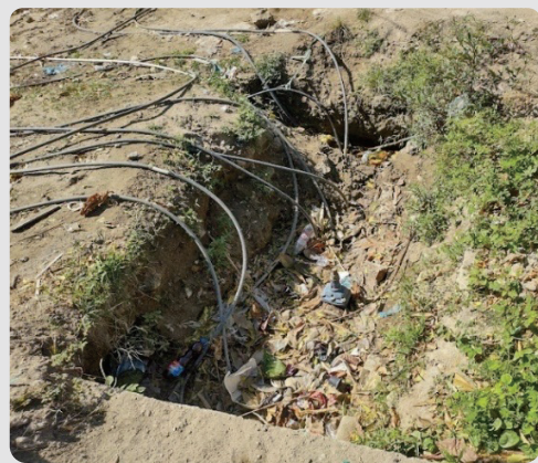
Foto 7 Conexión de agua al acueducto asentamiento Nueva Esperanza 2/02/2023
