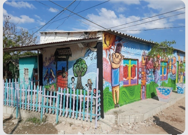
Foto 19 Fachada sitio de acogida "El País de los Sueños" y unto de hidratación con llaves al exterior. Asentamiento La Concepción 31/01/2023
