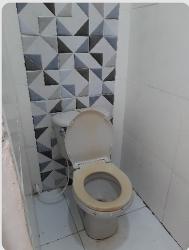
Fotos 20 y 21 Unidad sanitaria – inodoro y lavamanos del sitio de acogida "El País de los Sueños" en asentamiento la Concepción. 31/01/2023
