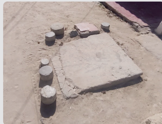
Foto 10 Registro aguas residuales y excretas - Renacer 30/01/2023
