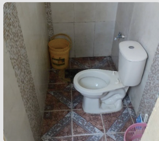
Foto 11 Unidad sanitaria familias asentamiento - Renacer 30/01/2023
