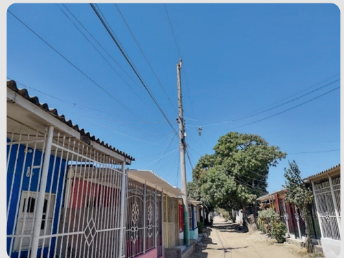
Foto 3 Conexión eléctrica asentamiento Villa del Rey. 2/02/2023
