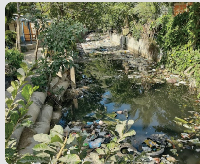
Foto 14 Manejo inadecuado de los residuos sólidos La Concepción 31/01/2023
