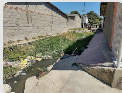
Foto 6 Canales abiertos de aguas grises asentamiento Villa del Rey. 2/02/2023
