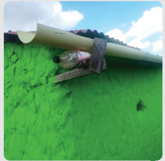
Foto 7 Adecuaciones para recolección de aguas lluvias Villa Ramon 19/01/2023
